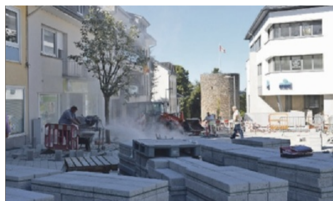
Die letzten Pflastersteine verlegt. Anwohner beschwerten sich über den vielen Staub. Eine Lösung wurde gefunden.
